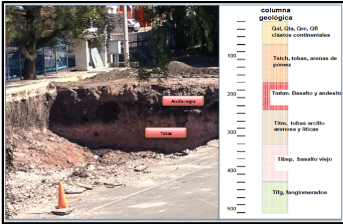
Figura 4.11: Capas de suelo del edificio de posgrado.
