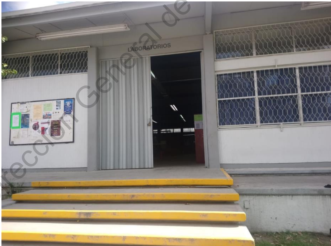
Figura 34. Vista exterior del acceso principal a los talleres de electromecánica. (Fotografía tomada a las 11:35am, octubre).
