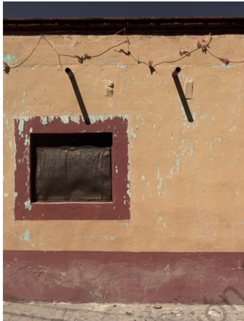
FIGURA 27 [Montserrat Ramírez] Fachada en San Nicolás.
