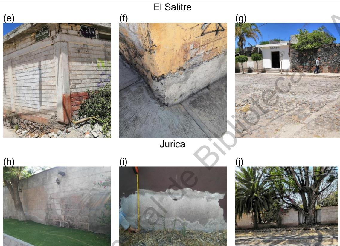
Figura 15. Afectaciones a causa de las inundaciones en la colonia Jurica y El Salitre.
