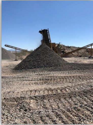
Figura ¡Error! No hay texto con el estilo especificado en el documento.. 10 Muestreo del agregado grueso del banco de materiales. Fuente: Elaboración propia.
