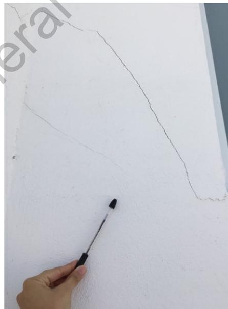
Figura 1.6 Grietas generadas después de las lluvias en una edificación construida sobre suelo expansivo en Querétaro, México.
