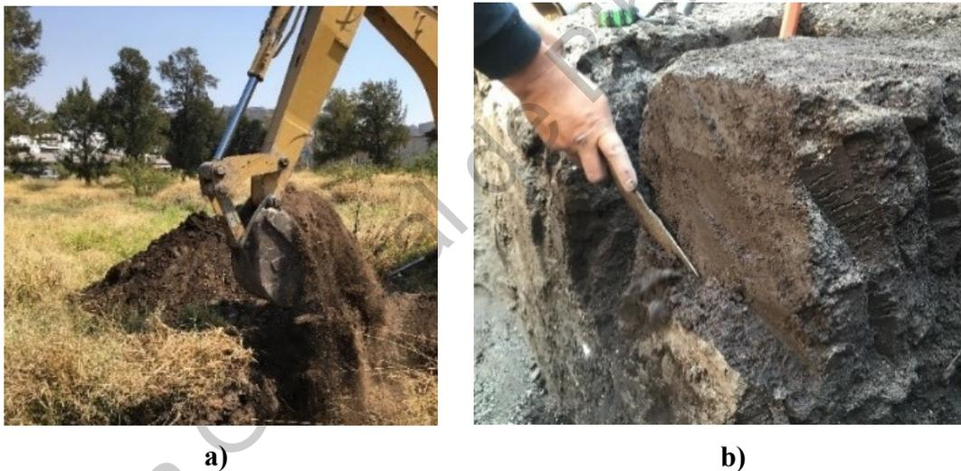
Figura 6.3 a) Excavación de un pozo a cielo abierto PCA. b) Labrado de la muestra inalterada.
