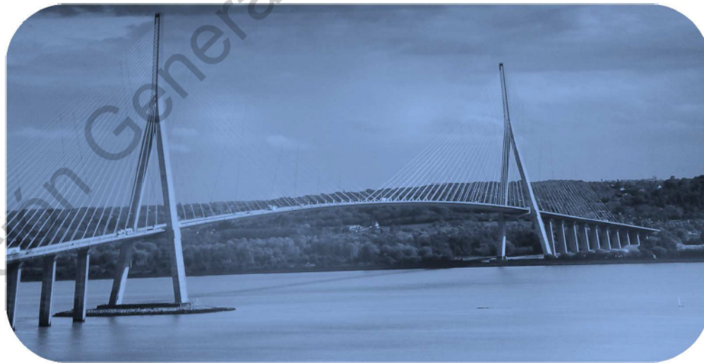
Figura 34. Fotografía de Puente de Normandía. Cortesía Dr. Moisés Arroyo Contreras
