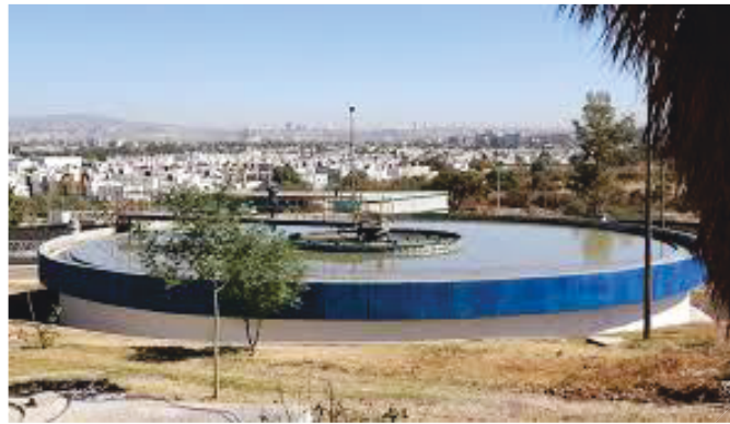
Figura 5.7 Reactor en Planta Tratadora de Agua sujeto a investigación.
