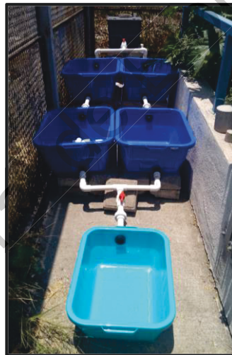
Figura 23. Instalación del sistema de tratamiento. Foto de Paola Martínez (2019).
