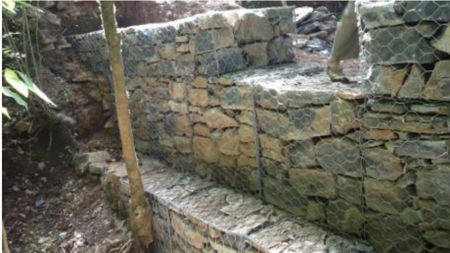
Figura 30. Presa de gavión, en la unidad de escurrimiento B2.
