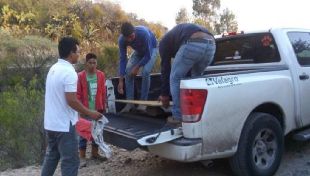
Figura 7. Instalación de vertedor en unidad de escurrimiento B1.
