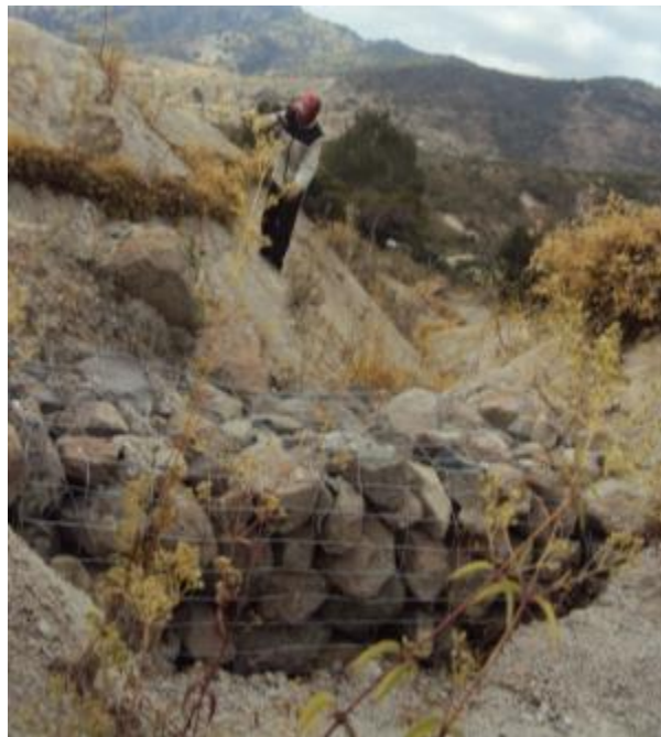
Figura 31. Establecimiento de presa de malla electrosoldada.
