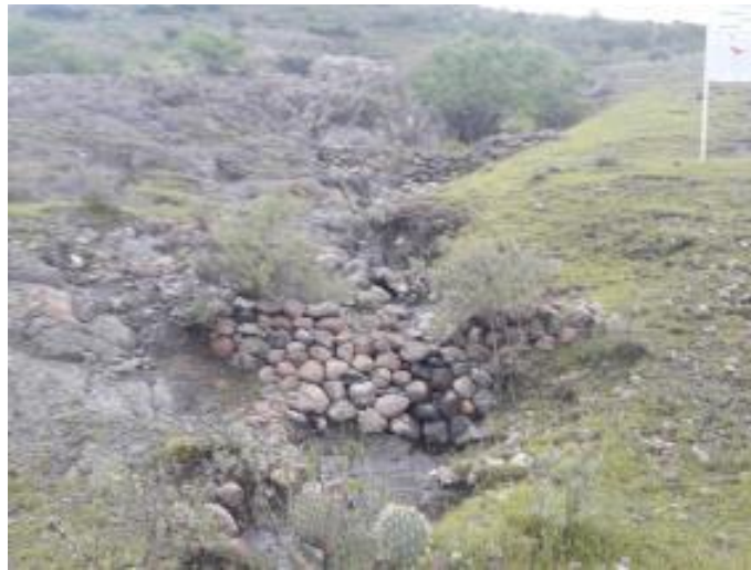
Figura 32. Presas de piedra acomodada en la unidad de escurrimiento B2.
