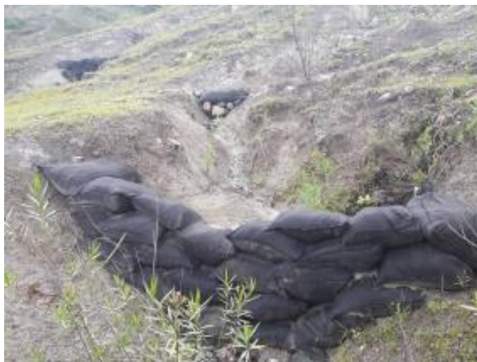
Figura 33. Presas de geocostales en la unidad de escurrimiento B2.
