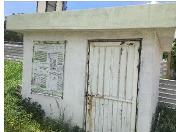
Colindante a la caseta se levantó una división de aluminio con su impacto de dar sombra y el viento. Las ventanas consisten de doble acristalamiento de 4mm, separación de 1.5cm con gas argón y marco de PVC y la puerta es de aluminio soldado de 6mm. Para soportar el alero de las casetas se colocó una losa volada de 15 cm por cada lado, con un chaflán de 30 cm con la finalidad de cubrir y mantener la tierra de un techo verde. El volado de la techumbre brinda protección
