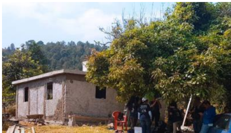
Figura 14 Prototipo de vivienda Construyendo ubicado en la comunidad de Tetela del Volcán en el Estado de Morelos 2018. Fuente: Construyendo.
