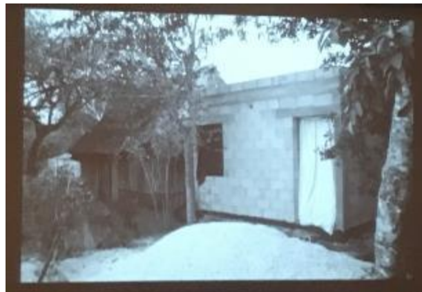
Figura 11 Prototipo de vivienda desarrollada y entregada por el FONDEN. Fuente: Juan M. Casillas Pintor
