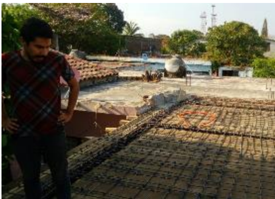
Figura 20 Arq. David supervisando obra Fuente: Erick David Ramírez Pérez.
