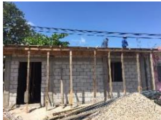
Figura 19 Construcción de vivienda Juchitán. Fuente: Erick David Ramírez Pérez.
