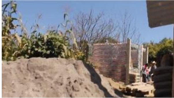
Figura 15 Vivienda con botellas de plástico realizada por VIEM MX en San Miguel Tecuanipa en Puebla. Fuente. VIEM MX
