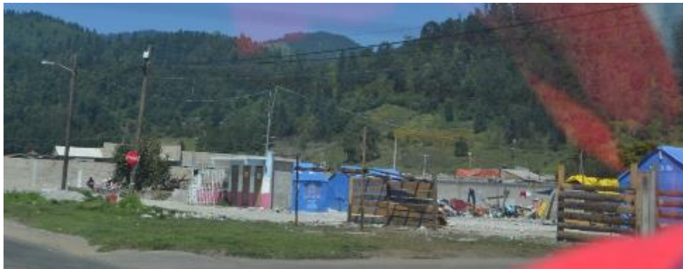
Viviendas después del sismo octubre 2017
