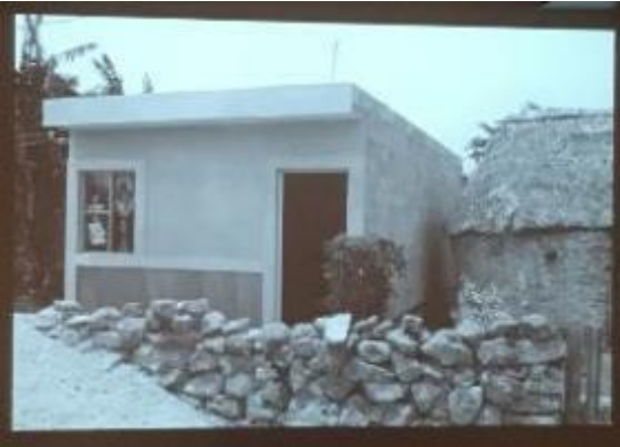
Figura 39 Prototipo pie de casa FONDEN otorgado a las familias afectadas por el huracán Isidoro en 2002. Fuente: Juan M. Casillas Pintor conferencia sobre el desastre Anáhuac 2018.
