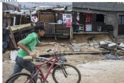
Figura 7 Vivienda daño parcial en el municipio de la Paz en el estado de Baja California, tras el paso del huracán Odile en 2014. Fuente: bcsnoticias,2014.
