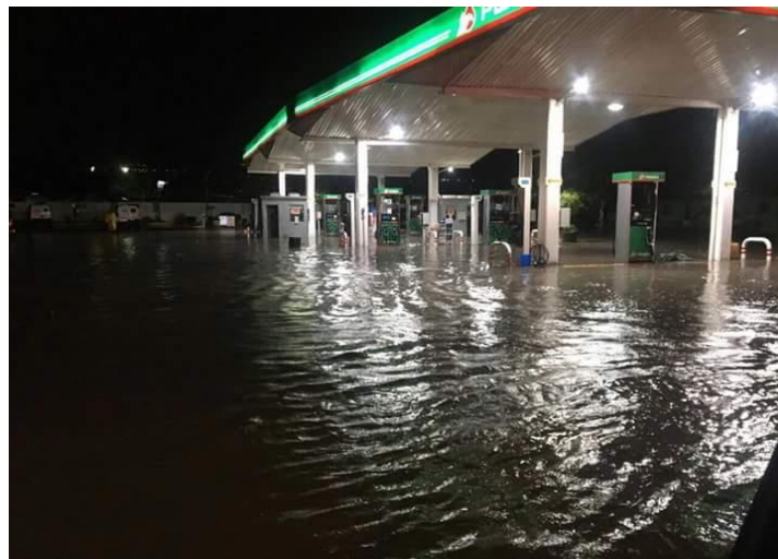
Figura 40. Inundación de gasolinera en acceso No. 6. Fuente: fotografías y elaboración propia.
