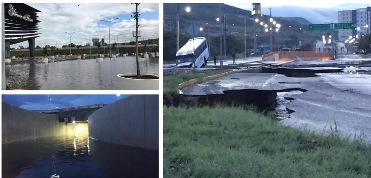
Figura 38. Afectaciones al noreste de la microcuenca.
