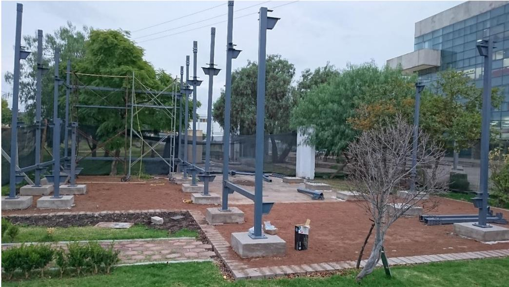
*Figura 4-28. Inicio de montaje de “Casa Solar Experimental” (montaje de columnas).*
