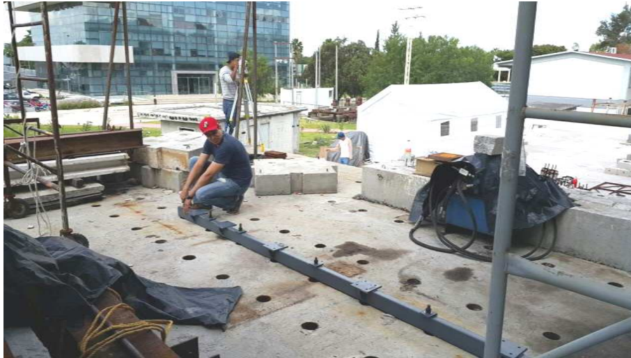
Figura 6-38 Fijación de estructura auxiliar (apoyo articulado) en losa de reacción para pruebas experimentales a escala real.
