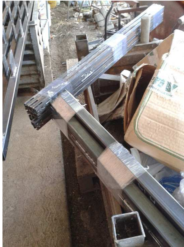
Figura 6-13 Almacenamiento de elementos de arriostramiento lateral (horizontales y diagonales) de propuesta de estructuración para su posterior traslado.
