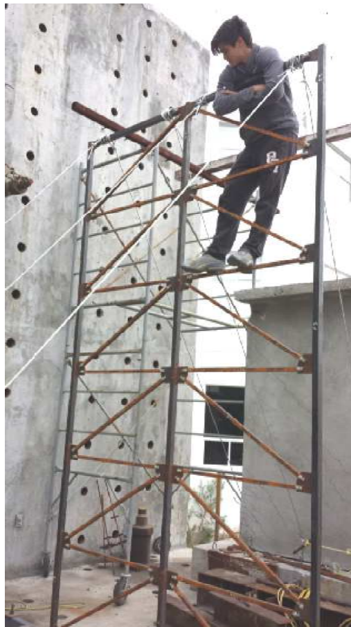
Figura 6-39 Colocación de sistema de arriostamiento lateral a base de cables de acero para recrear condiciones de apoyo de sistema de panel (articulado-articulado).
