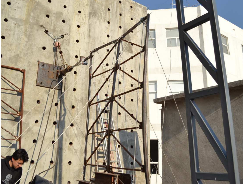
Figura 6-46 Sistema de panel simple cargado completamente con una carga lateral de 2.70 ton en promedio.
