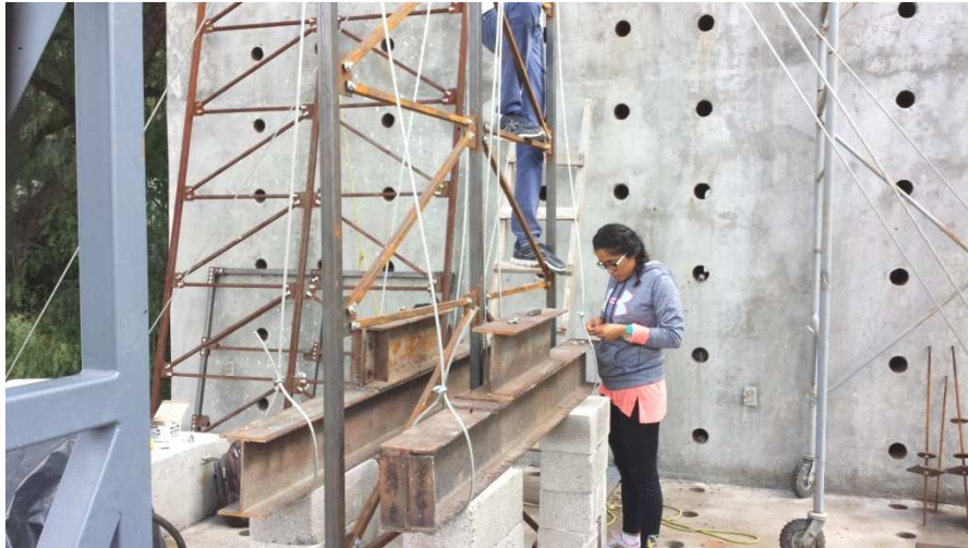
Figura 6-40 Aplicación de carga gravitacional (carga muerta + carga viva) mediante perfiles estructurales de peso equivalente a cargas de servicio.
