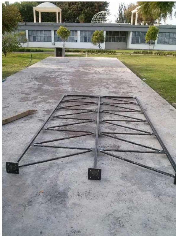
Figura 6-16 Montaje de especímenes de prueba in situ.
