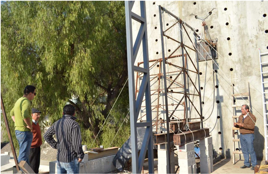
Figura 5-37 Colocación de cargas aplicadas sobre prototipo de prueba.
