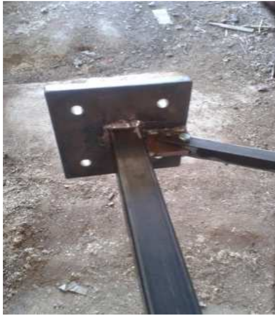
Figura 6-11 Barrenado de placas base y presentación de elemento de arrioste por medio de atornillamiento.
