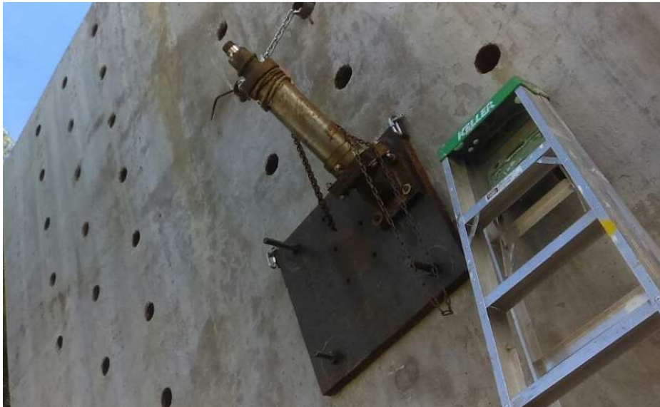
Figura 5-34 Colocación de cilindro hidráulico (carga lateral) en muro de reacción.
