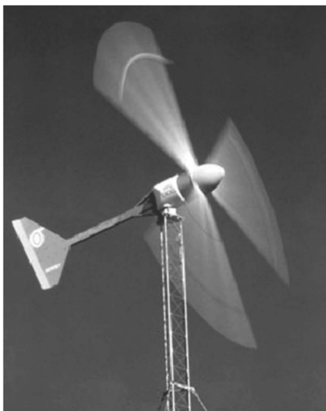
Figura 6. Turbina de viento pequeña con control de cabeceo pasivo. Fuente: Spera, 2009
