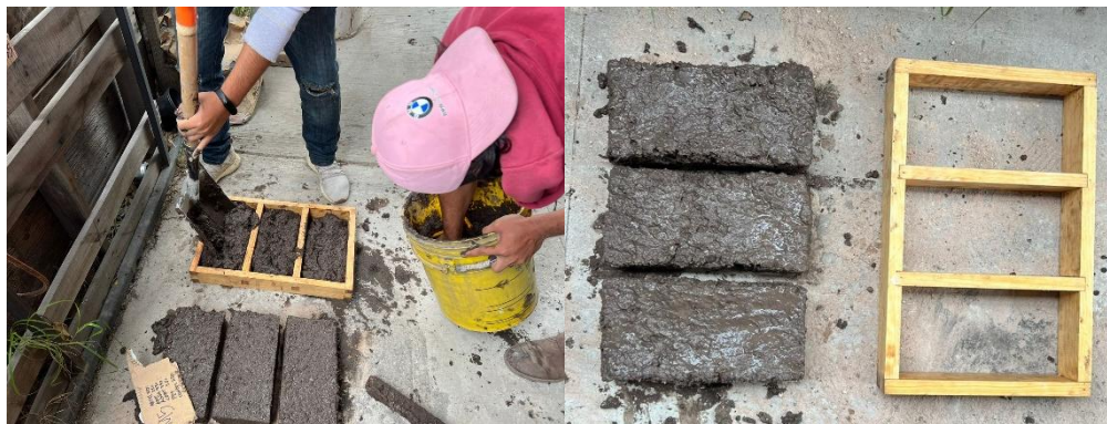
Figura 3-11. conformación de los tabiques en los moldes y desmoldeo.
