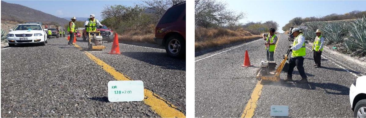
**Figura 3.26 Corte perimetral de la superficie de rodamiento.**
