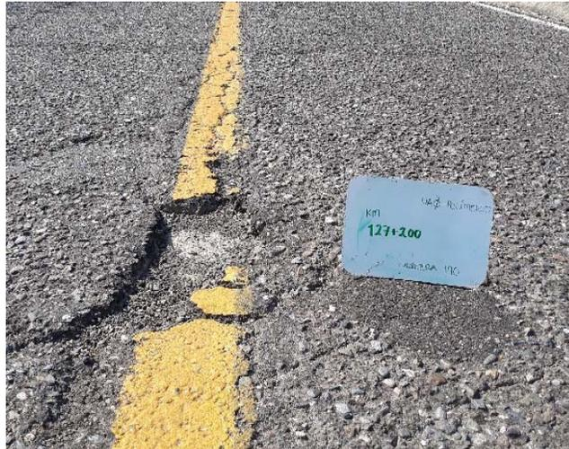
**Figura 3.24 Deterioro del pavimento.**
