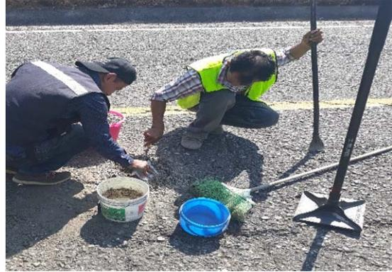
**Figura 3.28 Aplicación de la mezcla.**
