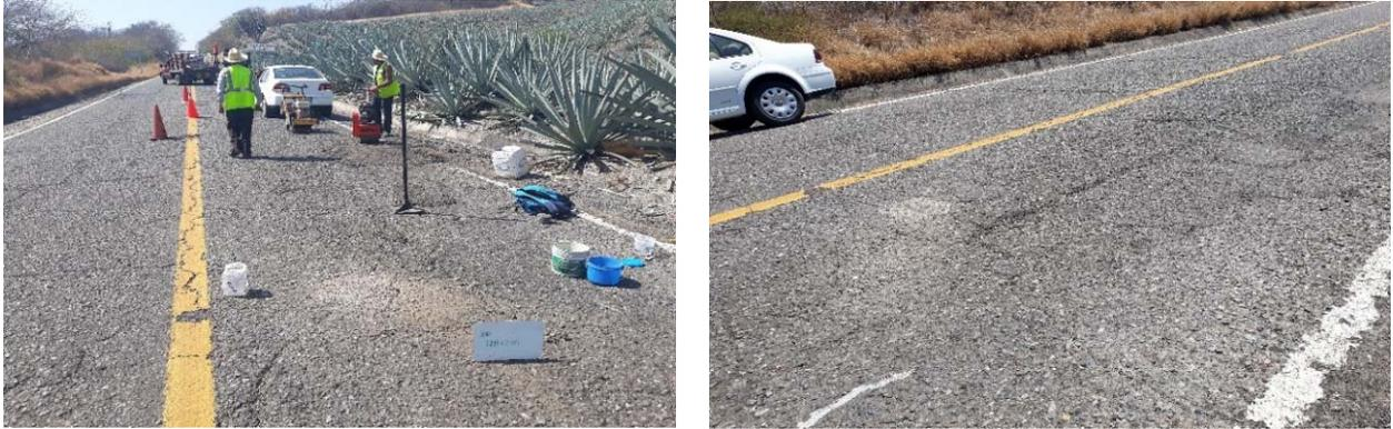
**Figura 3.42 Bacheo aislado con mezcla reciclada.**
