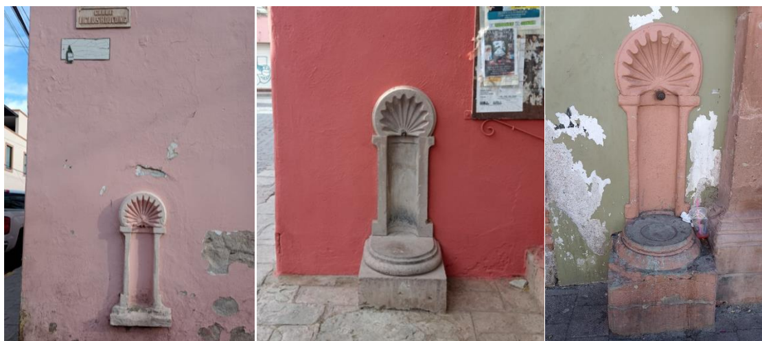
Figura 17 Llaves de agua comunitaria, 2024.
