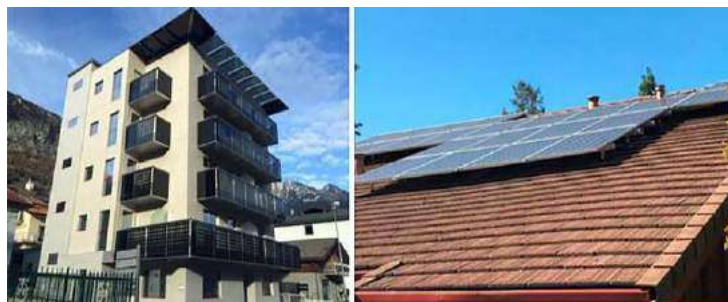
Figura 2.6: Aplicación de energía fotovoltaica en techos de edificios.
