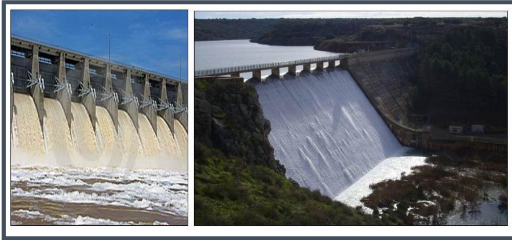
Figura 1.5 Vertedores de compuerta y de cresta libre Fuente: Villarino, O. A., 2010. Referencia Bibliográfica [1].
