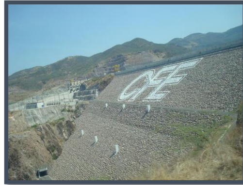
Presa de tierra y enrocamiento
