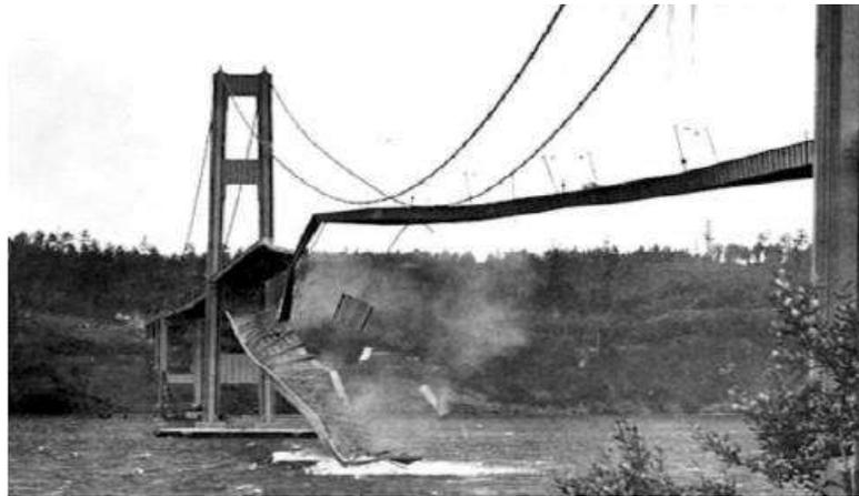
Figura 1.3 Colapso del puente Takoma Narrows tomada de la colección especial de la librería la Universidad de Washington, FAR017
