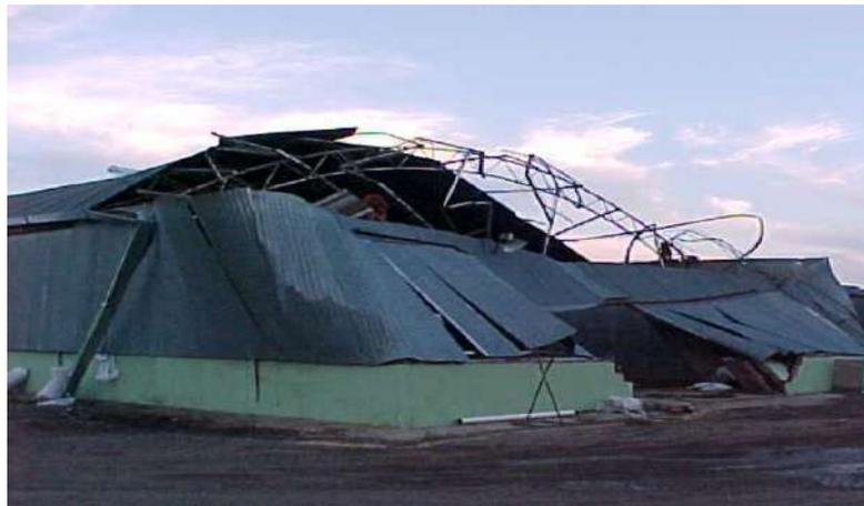
Figura 1.5 Pandeo general por presiones en muro barlovento tomada de (Balbastro & Sonzogni, 2008)
