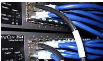
**Figura 2.34** Conexiones en un switch Ethernet.
