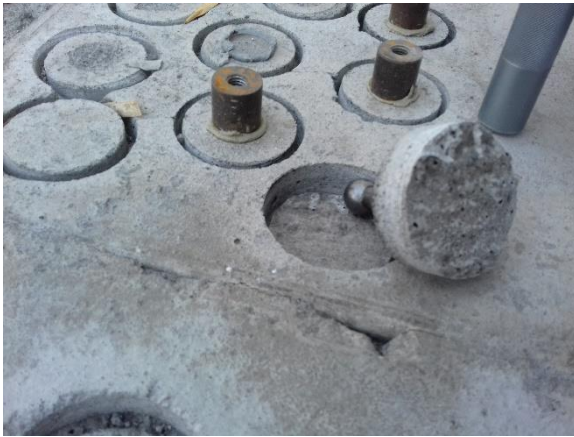
Figura 50.- Falla de la base donde el mortero está adherido, (Bernabé C.)
