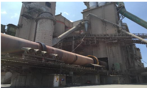
Figura 7. Horno rotatorio para calcinar y transformar químicamente la materia prima y Clínter de cemento (Fuente propia)
