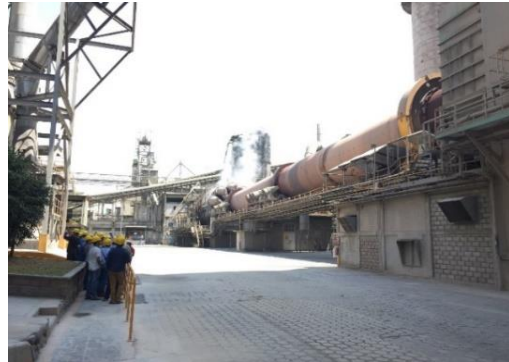
Figura 6. Horno rotatorio para obtención del Clínter de cemento (Fuente propia).
