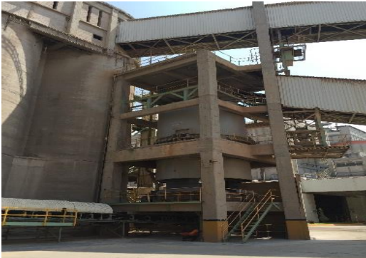
Figura 5. Depósitos de almacenamiento del material crudo prehomogenizado, antes de entrar al horno rotatorio (Fuente propia).
