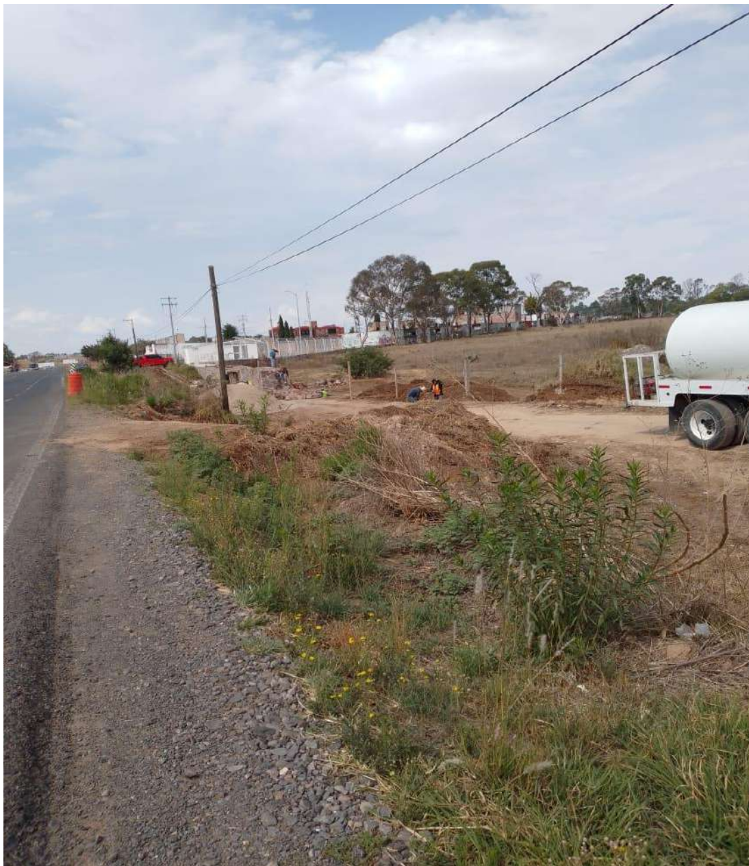
Figura G. Fotografía tomada en carretera 300, obra de construcción de banquetas en la comunidad de San Miguel Dehetí
