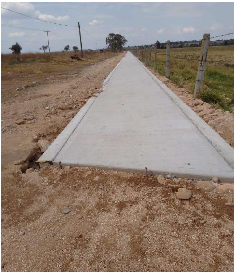
Figura H. Fotografía tomada en carretera 300, obra de construcción de banqueta en la comunidad de san Miguel Deheti
