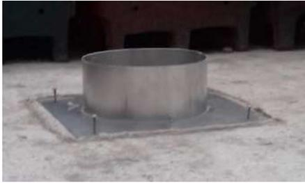
Figura 67. Colocación de la base impermeable
