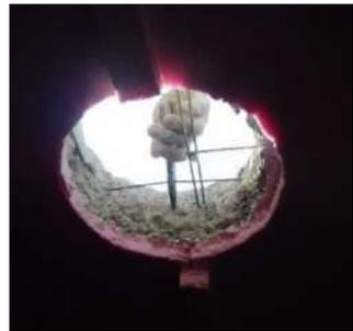
Figura 65. Corte de estructura metálica
