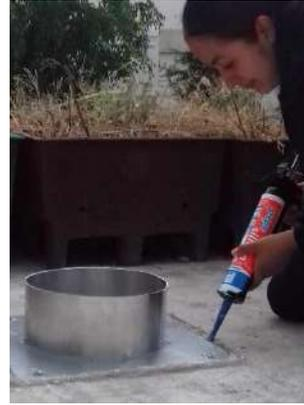
Figura 68. Aplicación de sellador en el perímetro
