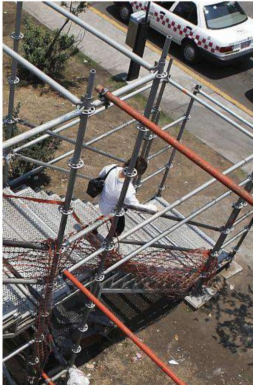
**Figura 2.3** Puente peatonal con estructuras inestables.
