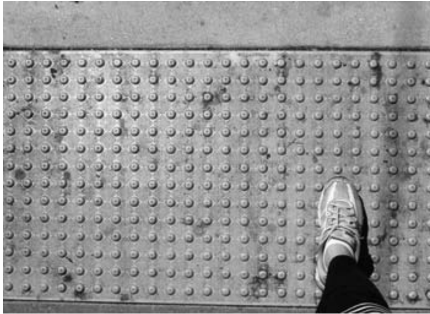
Figura 119. Textura de alerta de 80 cm de profundidad para avisar cambio de nivel e inicio de rampa. San Francisco, EE.UU. Ciudades y espacios para todos. 2010
