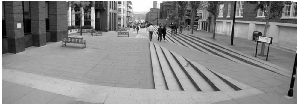
Figura 5. Rampa incorporada a escalera. Londres, Inglaterra. Ciudades y espacios para todos. 2010
