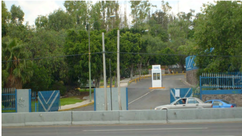
Figura 68. Acceso Av. 5 de Febrero. Elaboración propia. 2011.
