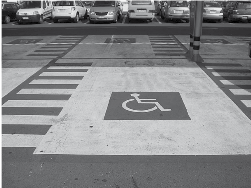
Figura 113. Estacionamiento de buenas dimensiones y señalización. Ubicarlos todos juntos favorece el uso correcto de éstos. Ciudades y espacios para todos. 2010
