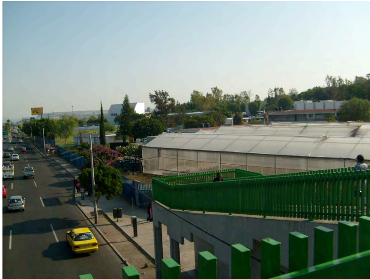
Figura 21. Puente peatonal Av. 5 de Febrero. Elaboración propia.2011
