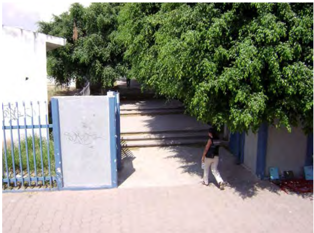
Figura 80. Acceso peatonal 5 de Febrero. Elaboración propia. 2011.
