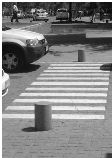
Figura 124. Los pilotes interfieren con el cruce peatonal. No deben ubicarse en los centros de éstos. Ciudades y espacios para todos, 2010.
