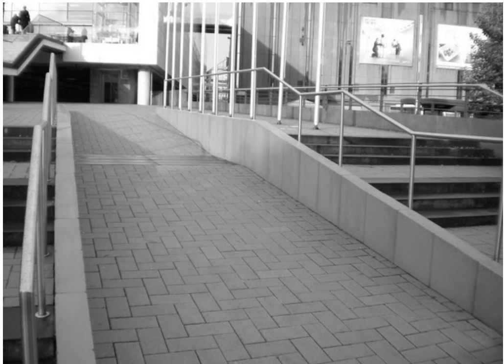
Figura 120. Rampa alternativa a escaleras en acceso a recinto. Feria Colonia, Alemania. Ciudades y espacios para todos. 2010
