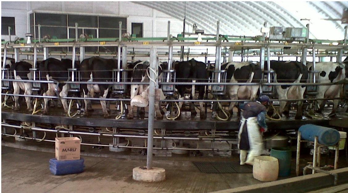
Figura 8 Sala de ordeño de carrusel línea de leche de 3 pulgadas con 2 tanques de recibo de leche en extremos opuestos del sistema.
