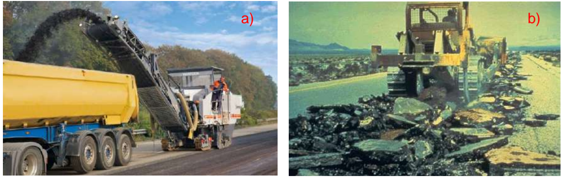
Figura 1- 4: Remoción de las capas asfálticas dañadas.
