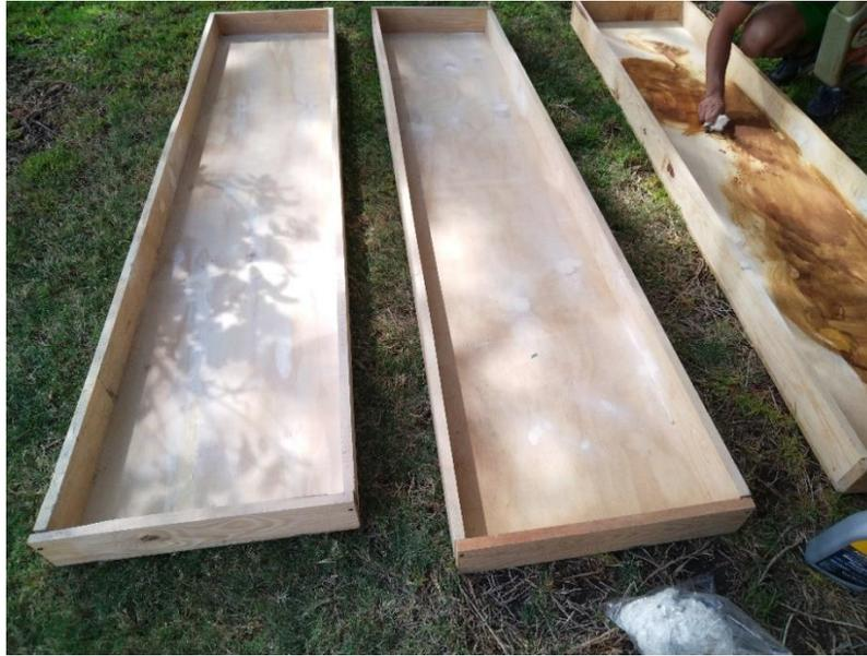
**Figura 4.8** Cimbra de madera para la construcción del MPM
