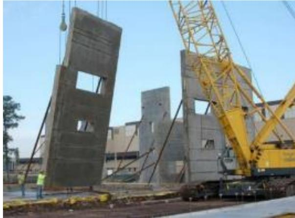
**Figura 2.4** *Montaje de muro tilt-up* (El Tilt-Up y Las Edificaciones Industriales - 360 EN CONCRETO, *n.d.*)
