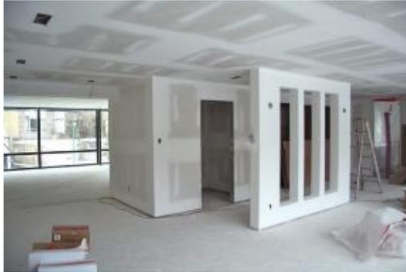
**Figura 2.6** Sistema de construcción de muros Drywall (Drywall - Home Solution, n.d.)
