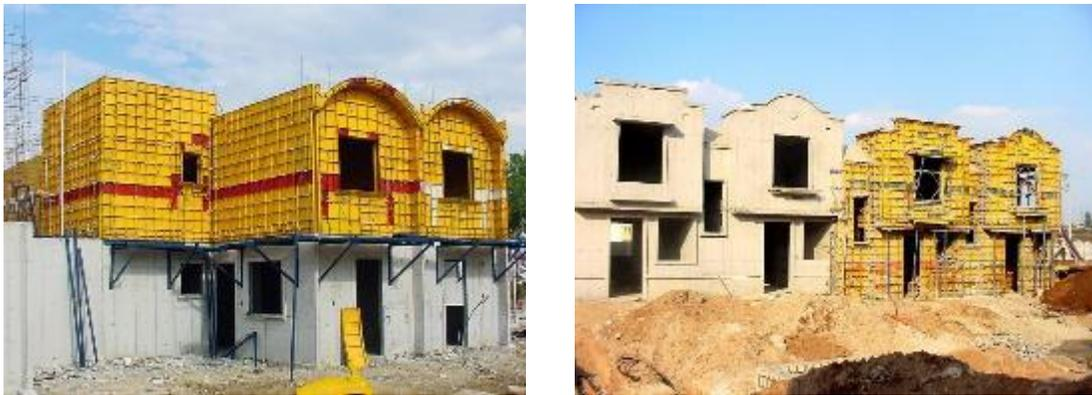
**Figura 2.10** Sistema constructivo de vivienda con moldes en Torreón, Coahuila, México. (Molde Total, n.d.)
