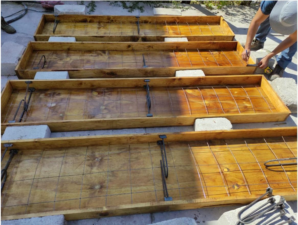
**Figura 4.18** Molde de construcción del muro panel modular
