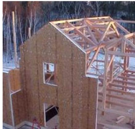
a) *Panel aislado estructural fabricado con poliestireno*      b) *Panel aislado estructural fabricado con poliestireno*
