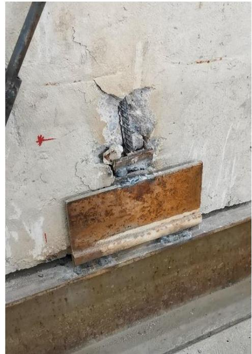
b) Falla en la soldadura de conexión
