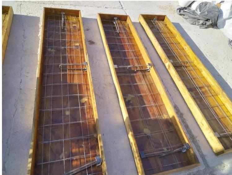
**Figura 4.9** Armado de malla electrosoldada para el MPM
