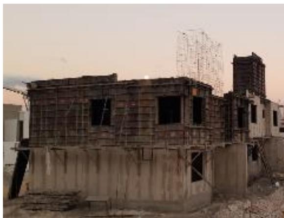
**Figura 2.9** *Construcción de muros de concreto con uso de moldes, Guadalajara 2022.
