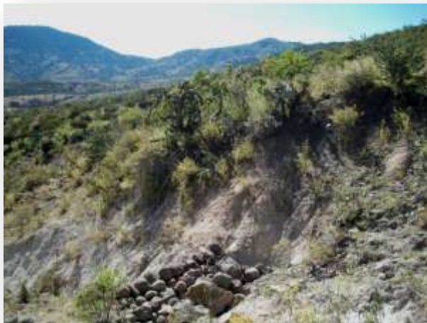
Figura 14. Cárcava con obras de control de erosión.
