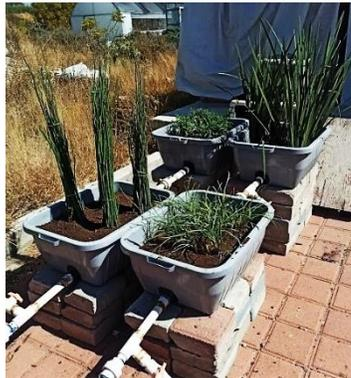
Figura 5 Humedal artificial de flujo subsuperficial horizontal (HAFSH)
