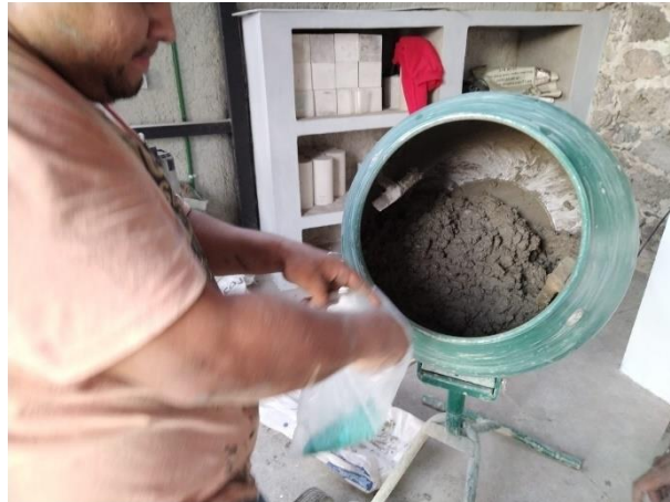
Figura 71. Mezcla de concreto homogénea.
