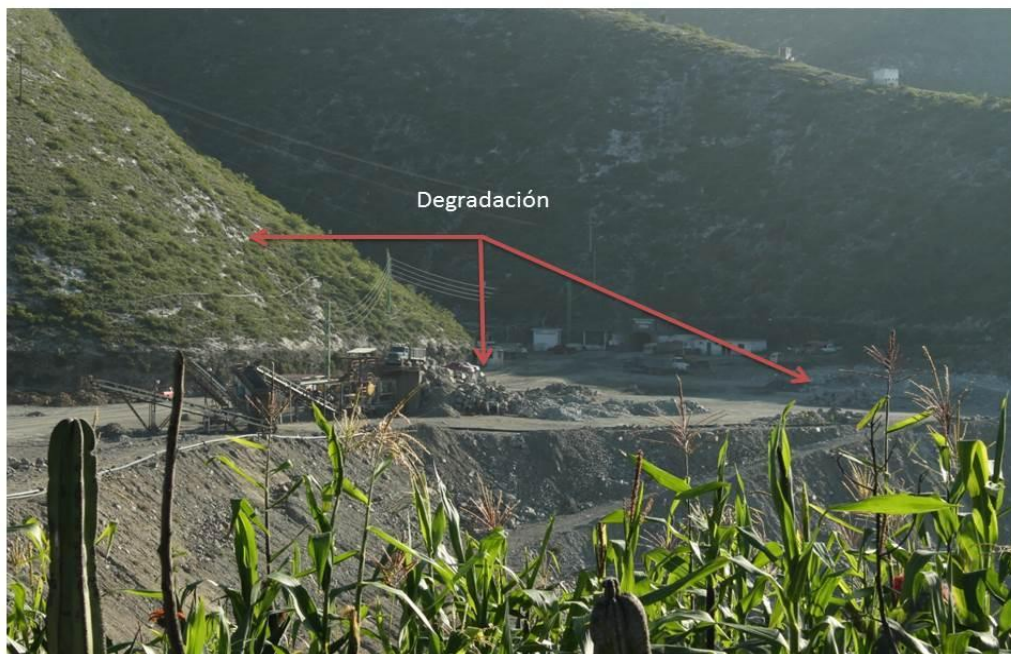
Figura 14. Aspecto del patio de trituración y maniobras a la entrada de La Negra desde El Huizache. Fuente: Elaboración propia
