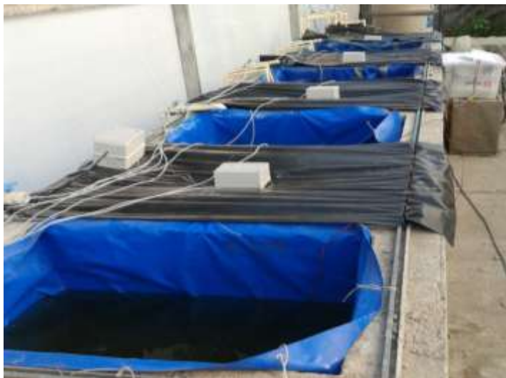
Figura 4.3. Sistema de control de temperatura y fotoperiodo instalado en los estanques de producción de renacuajo de rana toro
