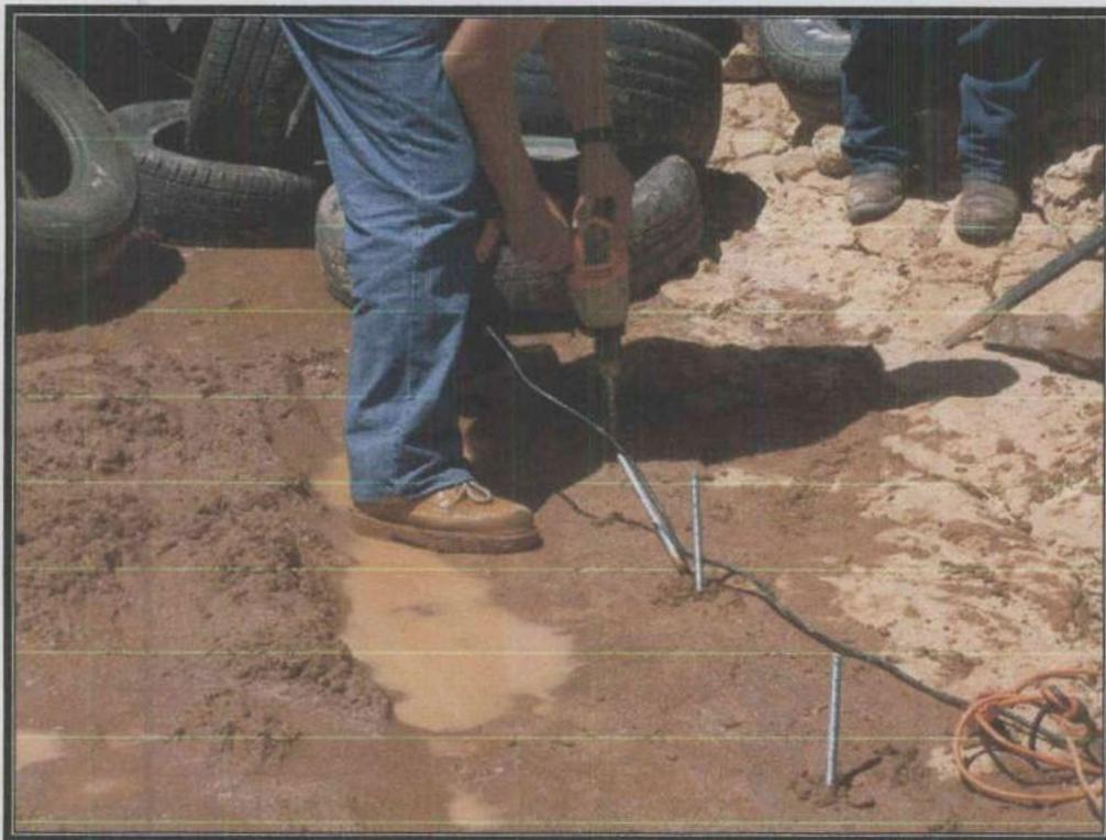
**Figura 52. Procedimiento de anclaje de espigones o tornillos**
