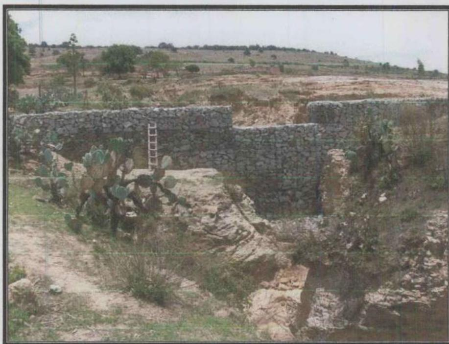
**Figura 43. Sección Mario modificada al término de la construcción**
