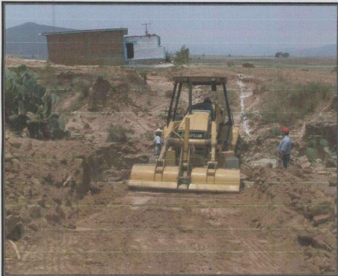
**Figura 39. Desplante de la Sección Hidráulica de la Sección Mario con Maquinaria Pesada**
