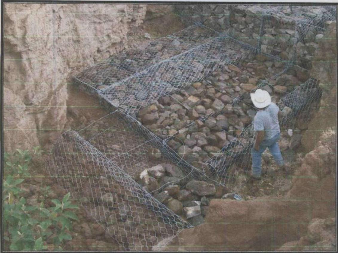
**Figura 41. Corrección por condiciones de sinuosidad del cauce en la Sección Mario**
