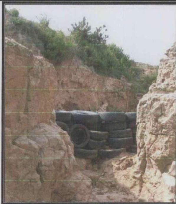
Figura 55. Obra de llantas terminada aguas arriba y aguas abajo.
