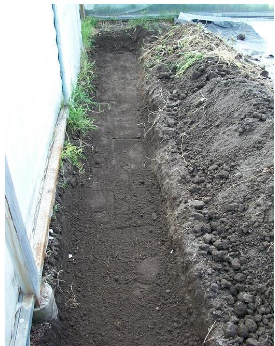
Figura 3.7 Cepa para tubería.
