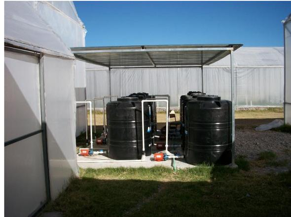
Figura 3.5 Protección solar de depósitos.
