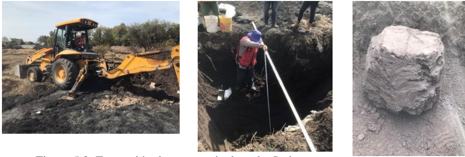
Figura 5.2. Extracción de muestra inalterada, Jurica.
