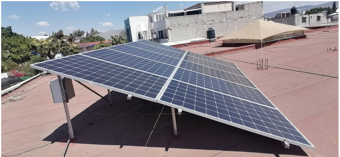
Imagen 8: SFVI usado para comprobación del método OCF (vista lateral).
