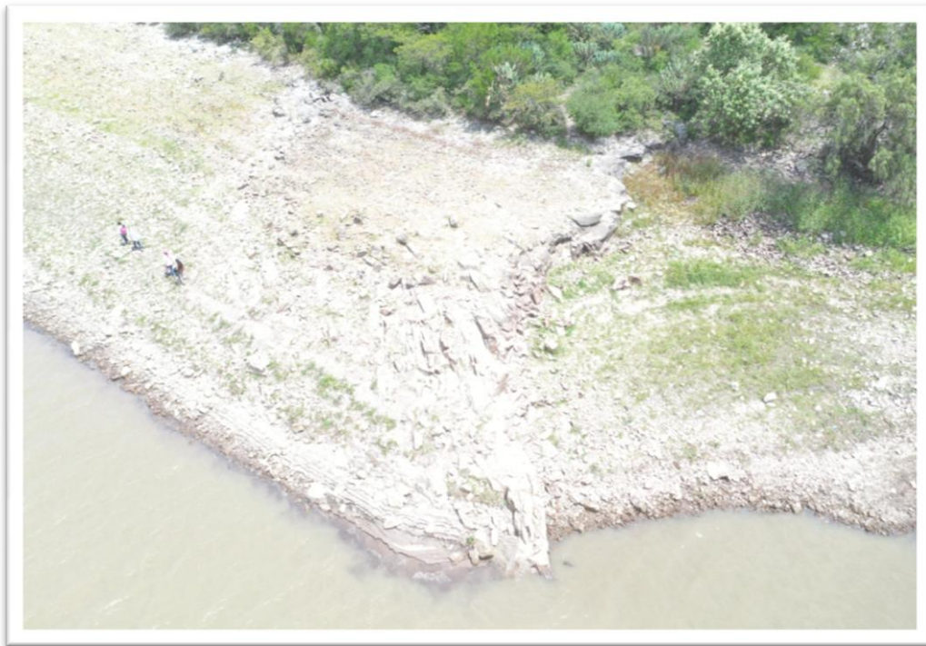
Ilustración 10 Capítulo I, erosión por escurrimientos de lado izquierdo del vaso
