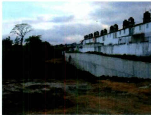
Foto 2. Muro de retención en Peñuelas Querétaro Qro.
