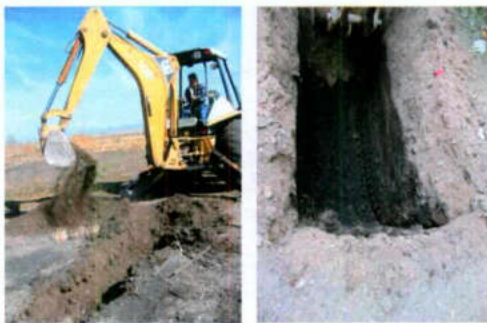
Foto 2. Excavación de pozo a cielo abierto por medio de una retroexcavadora. (Chávez, 2009)
