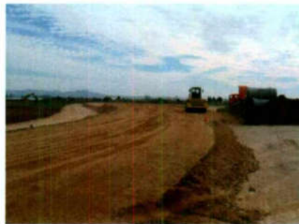
Foto 4. Construcción de terraplén en el anillo Vial Junípero Serra
