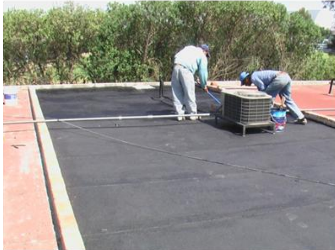
Figura 13. Instalación del impermeabilizante asfáltico
