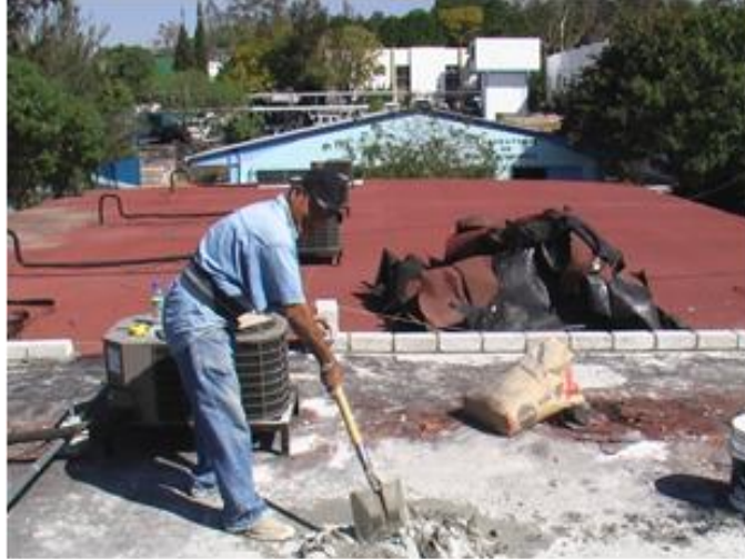
Figura 9. Preparación de la losa para la instalación del sistema impermeable
