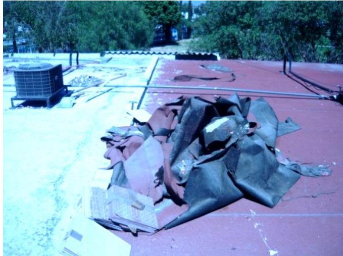
Figura 16. Instalación de la superficie del control contiguo
