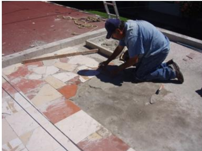
Figura 14. Instalación de la loseta
