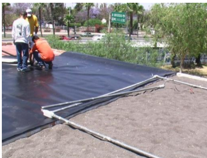
Figura 15. Instalación de la membrana
