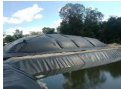
Imagen 85. Biodigestor tipo laguna (Nahed, 2018).
