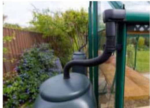
Imagen 89. Cisterna para captación de agua de lluvia (FAO, 2013).
