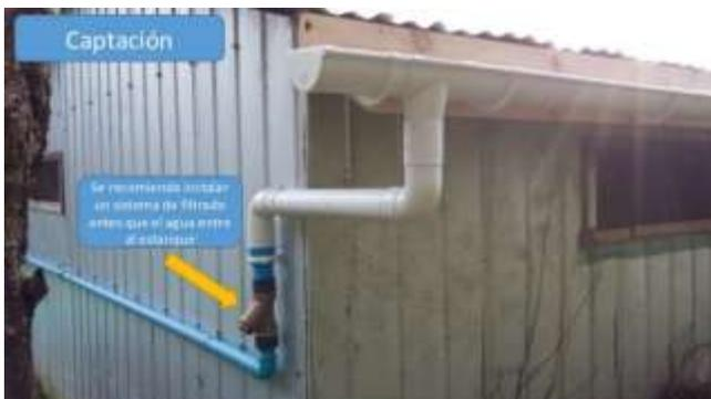
Imagen 88. Tubo conductor (Segovia et al., 2012).
