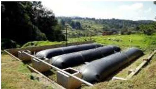
Imagen 84. Biodigestor tipo modular (Nahed, 2018).
