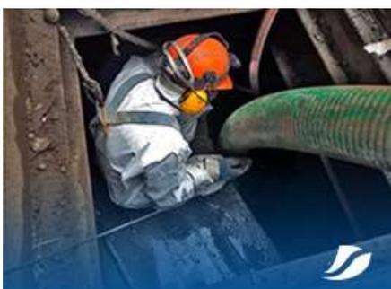
Imagen 86. Extracción de lodos acumulados ( Gastón et al., 2008).
