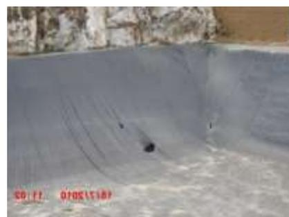
Imagen 87. Fuga en la geomembrana (Montes, 2013).
