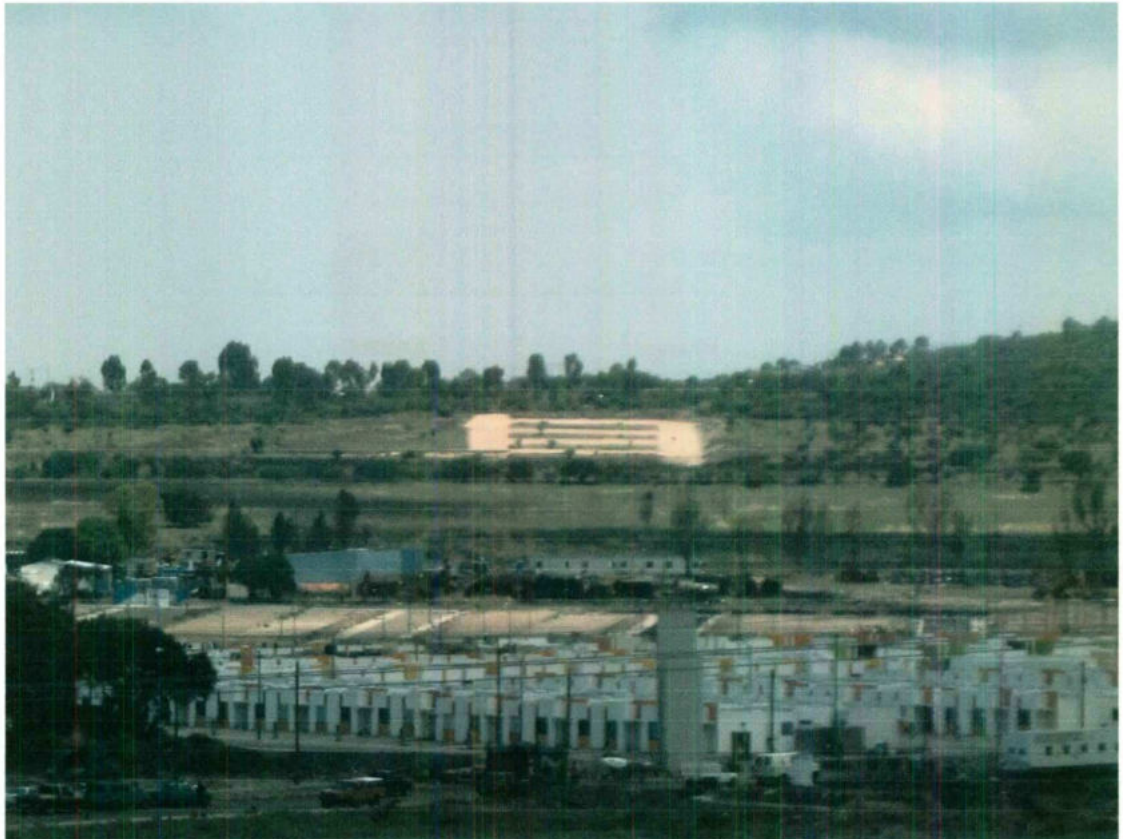
Vista general de la Obra
