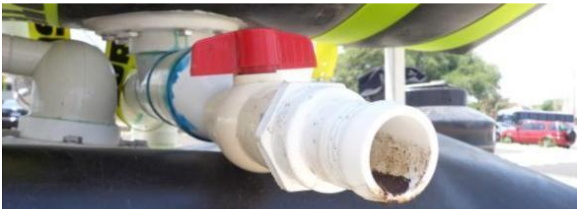
Figura 4.3. Válvula para desazolve.
