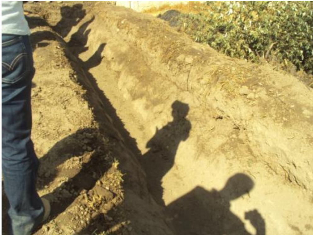
Figura 3.2. Típica zanja cavada para un biodigestor tipo salchicha.
