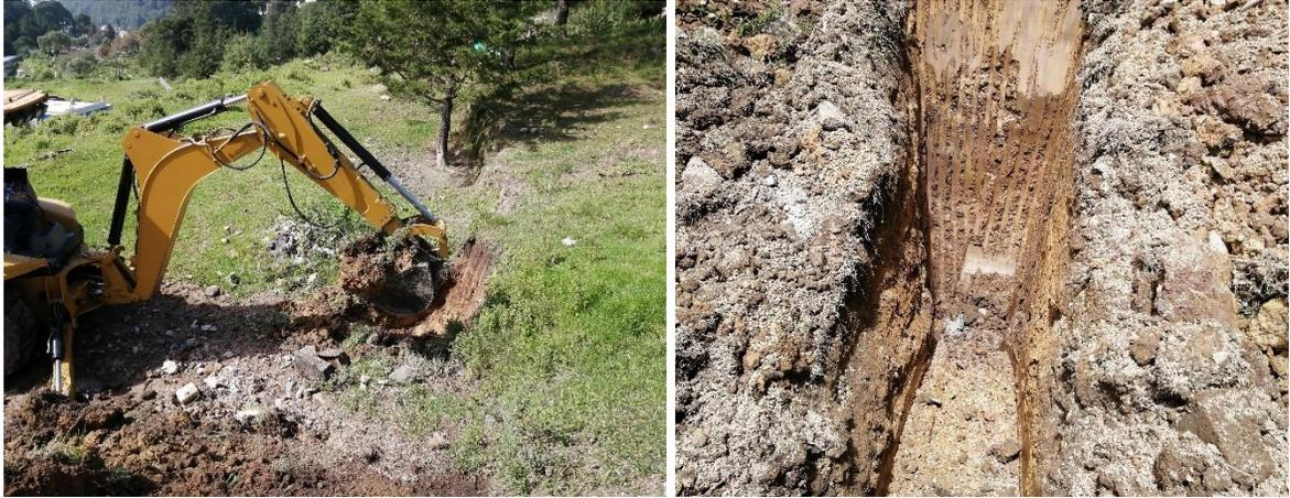
*Figura 5.4 Obtención de una muestra de suelo inalterada a través de un pozo a cielo abierto (PCA).*
