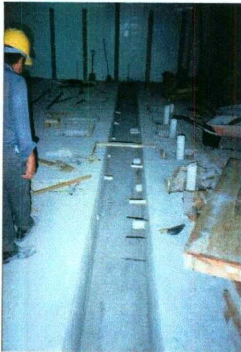
**Ducto preparado para la colocación de muros de tablaroca**
