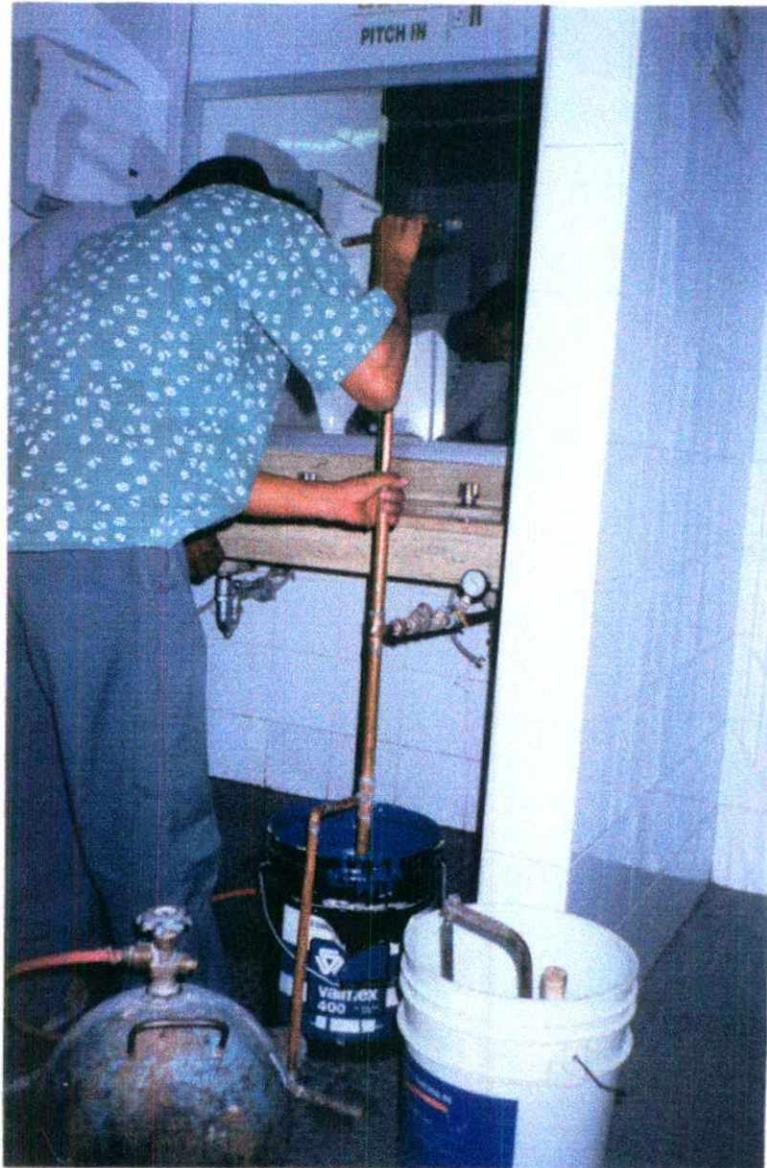
**Bombeo manual para someter la línea a una presión de 7 kg/cm<sup>2</sup>**
