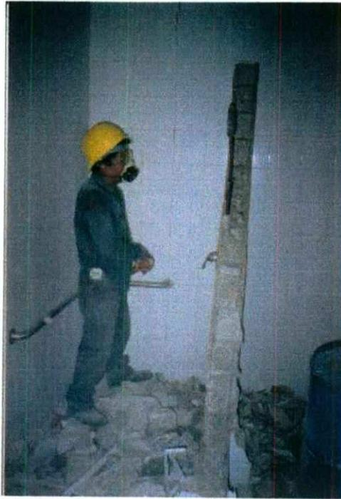
**Demolición de muros de mampostería**
