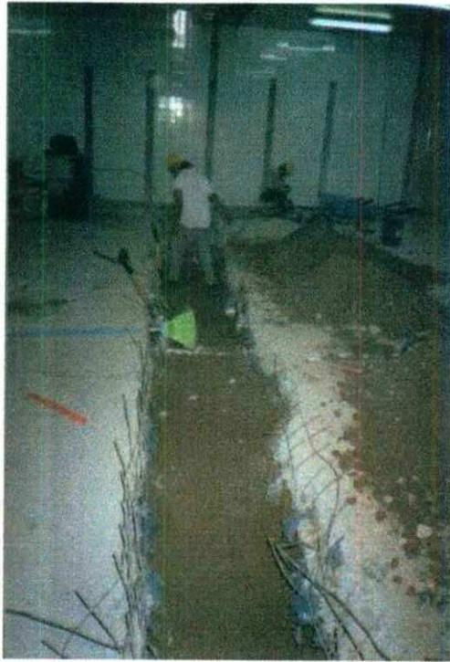
**Ruptura para ducto de instalaciones**
