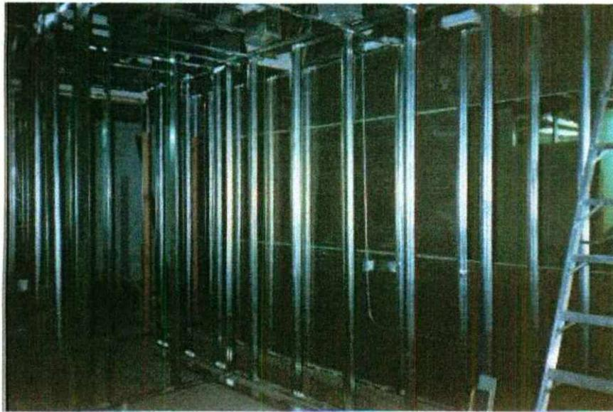
**Bastidor metálico para muros de tablaroca**
