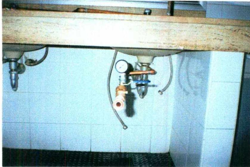
**Conexión de manómetro para Pruebas Hidrostáticas**
