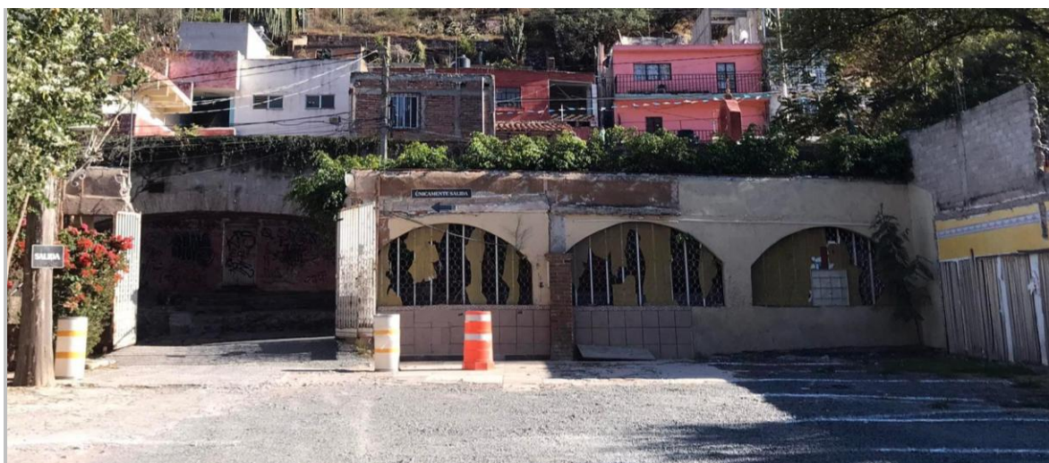
Imagen 27. En la fotografía se observa la entrada al estacionamiento del jardín de cerveza; aún puede verse parte de la estructura original de la casa que fue vendida. Fuente: Autoría propia.
