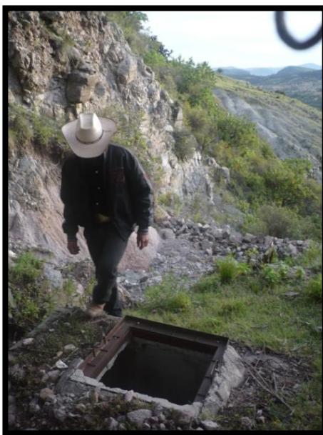
Figura 14. Obra de almacenamiento y distribución del agua del manantial del Pelón, del periodo de Antonio Calzada, abandonada. LEG, 2010.
